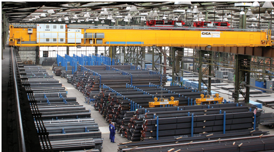
Mostový jeřáb GIGA s nosností 14,5 tuny s magnety pro transport profilových polotovárů
