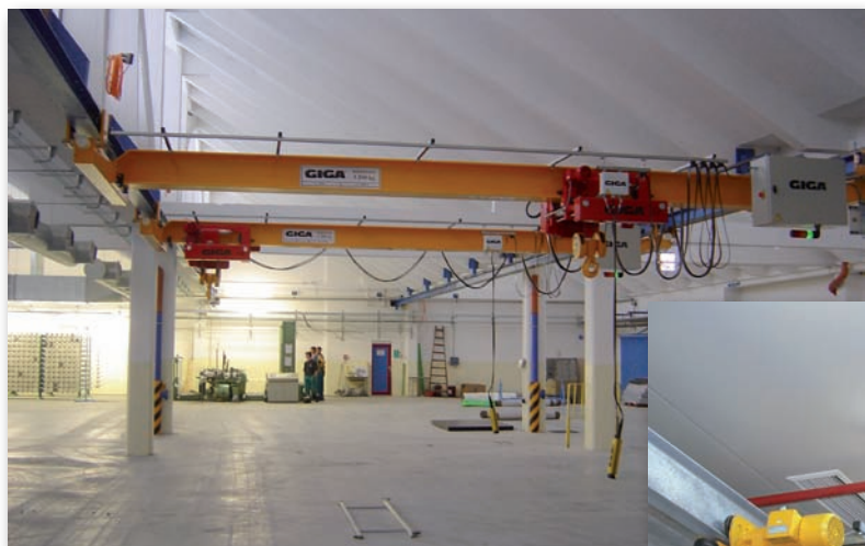
Подвесные мостовые краны GPMJ 3,2т/10м с электрической канатной талью
