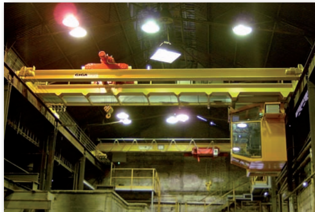
Мостовой кран GIGA mup GDMJ 3,2t/9,43m в сталелитейном исполнении с кабиной
