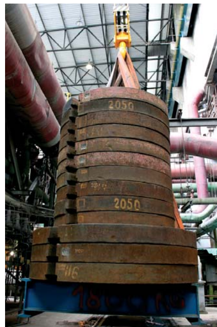
100 tun závaží při statické zkoušce jeřábu ...v klidu musí jeřáb unést 125 % své nosnosti
