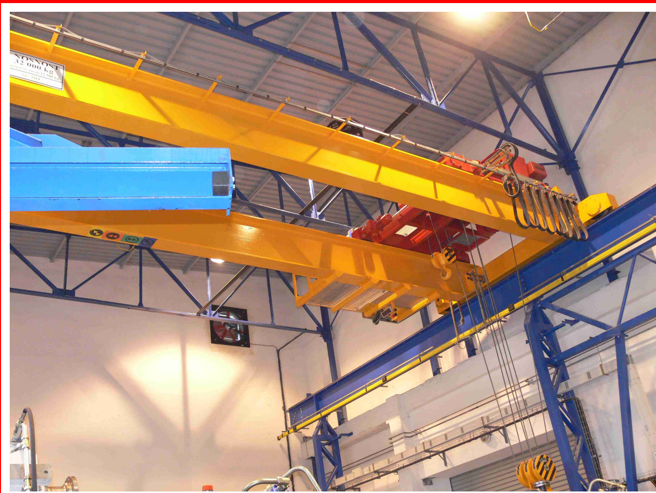
■ Dvounosníkový mostový jeřáb typ GDMJ 32t/12,5t/13,5m
